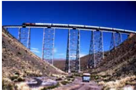
1987: »Viaducto La Polvorilla« bei San Antonio de los Cobres, Argentinien..
